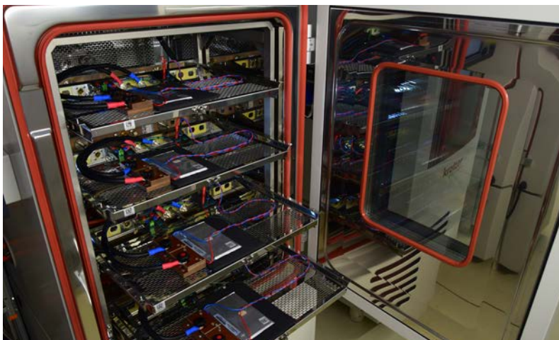
CRITT M2A - Banc d'essai cellule
