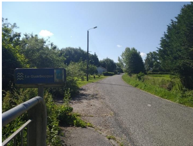
Figure 2 : Photographie - La Guarbecque dans le Marais Pourri à Norrent-Fontes (Source : AULA)
