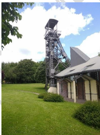
Figure 4 : Photographie - Chevalement de Marles-les-Mines (Source : AULA)
