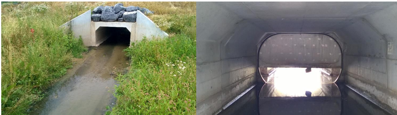
Figure 33 : Exemple d'ouvrage de régulation équipée d'une vanne dans le lit mineur d'un cours d'eau (Source : ARTELIA)
