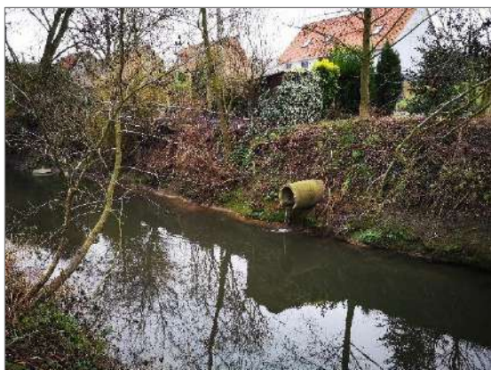
Figure 72 : Buse de rejet sur la rive droite de la Lawe au niveau de la zone d'étude
