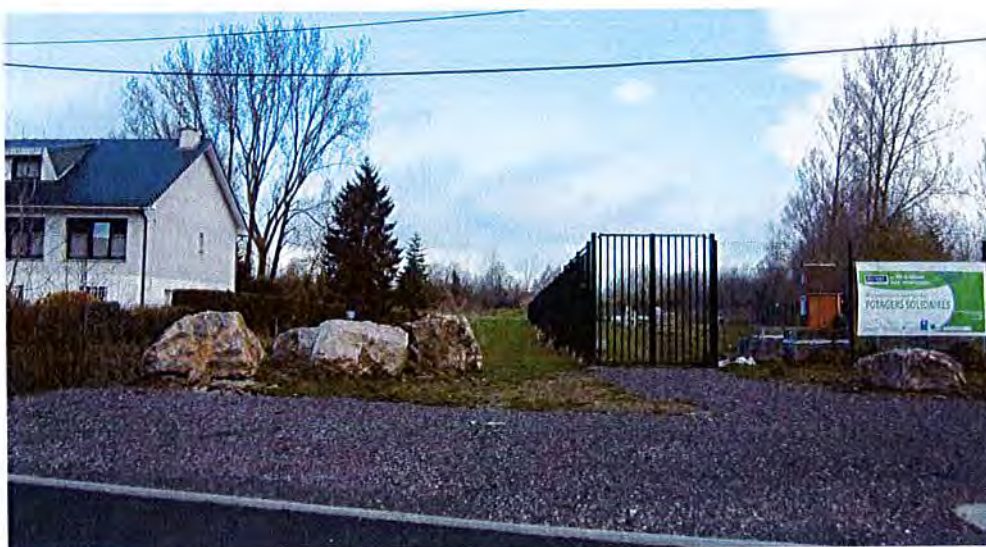
Accès au Parc du Quai de Bruay depuis la rue du Pré des Rois au sud – Jardins potagers solidaires
