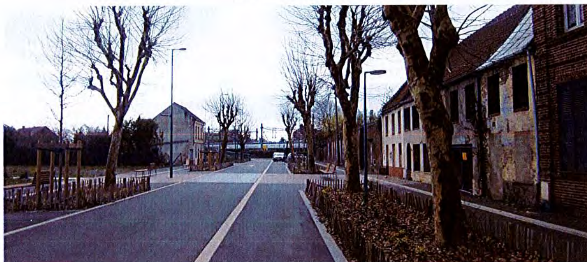
Portion rénovée de la rue de l'Horlogerie desservant les zones A et B. Les alignements d'arbres sont à conserver
