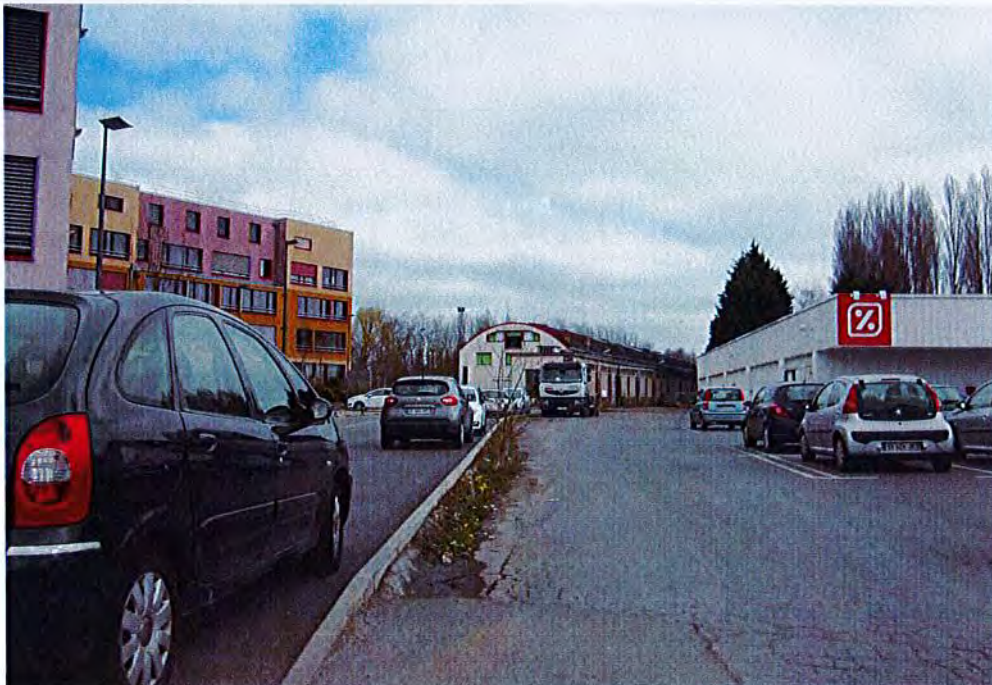
La zone et la construction à démolir (au fond) depuis la voie desservant les habitations collectives et les activités économiques et se rattachant à la rue Barbusse
