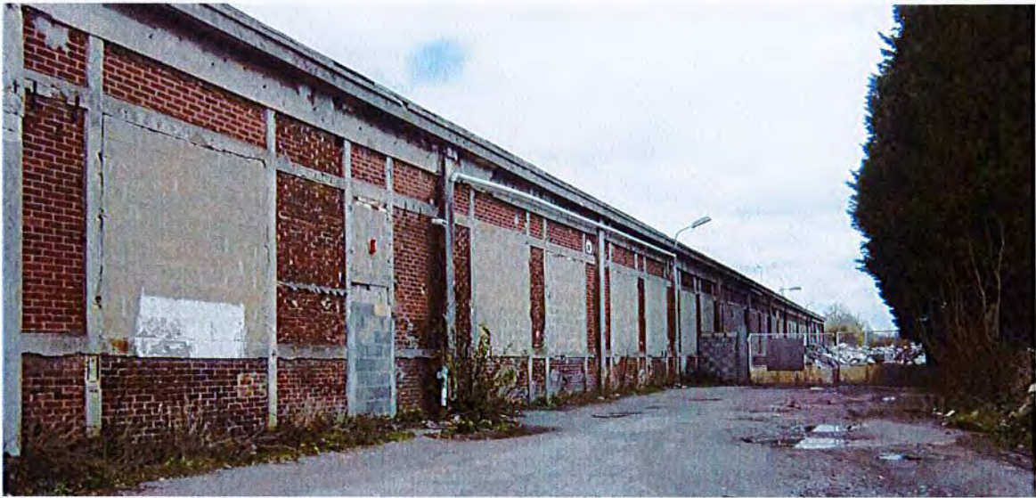
Les constructions présentes sur la zone qui devront être démolies
