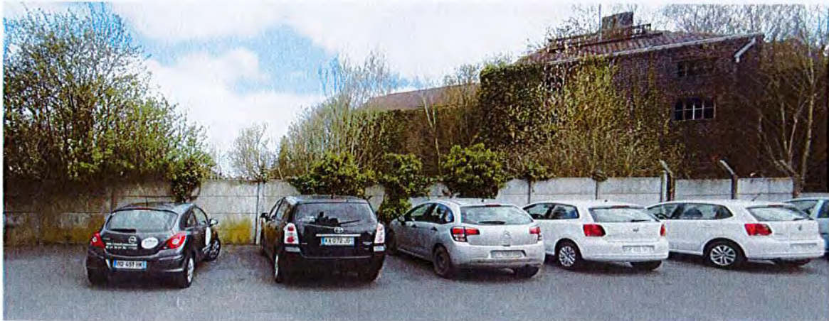
L'accès potentiel de la zone A depuis le parking de la rue A, Outrebon – la zone est en friche et possède d'anciens bâtiments à pouvoir être démolis
