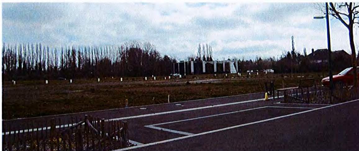
Vue sur la zone A depuis la rue de l'Horlogerie à l'ouest – La zone est en cours d'aménagement – le bâtiment d'activité économique reste en place
