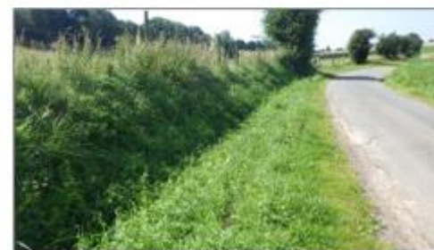
P : Fossé en bord de route et haies arbustives discontinues (en frange Nord-ouest de la zone)
