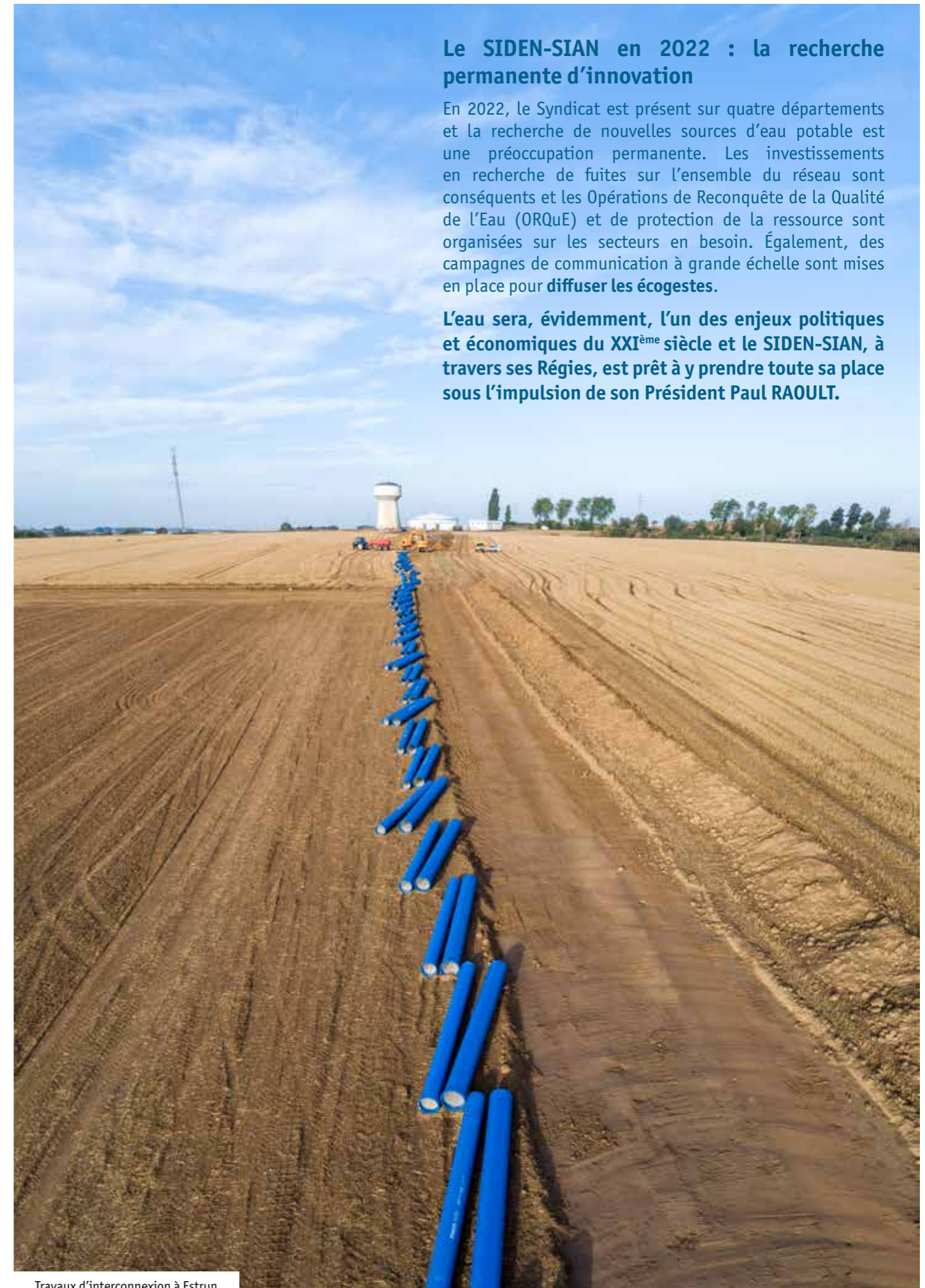
Travaux d'interconnexion à Estrun
