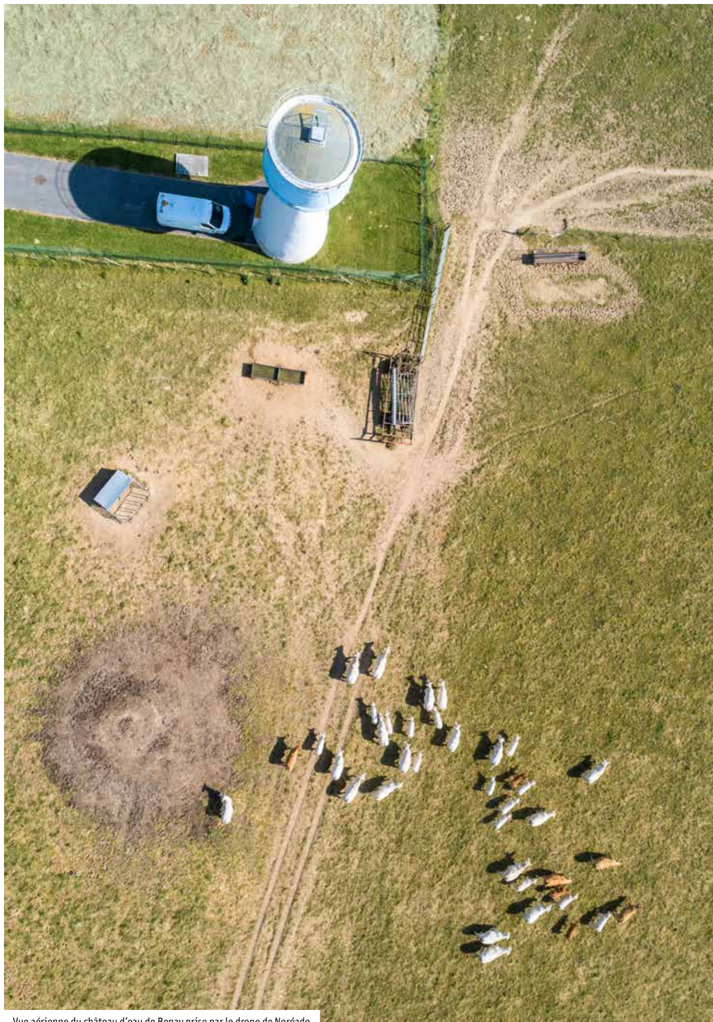
Vue aérienne du château d'eau de Benay prise par le drone de Noréade
