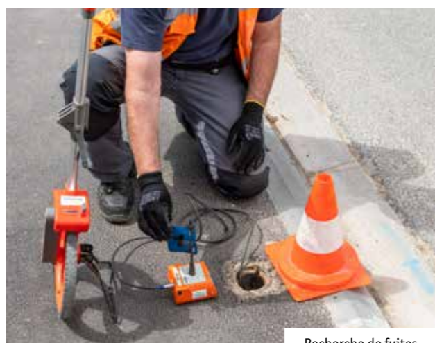
Recherche de fuites
