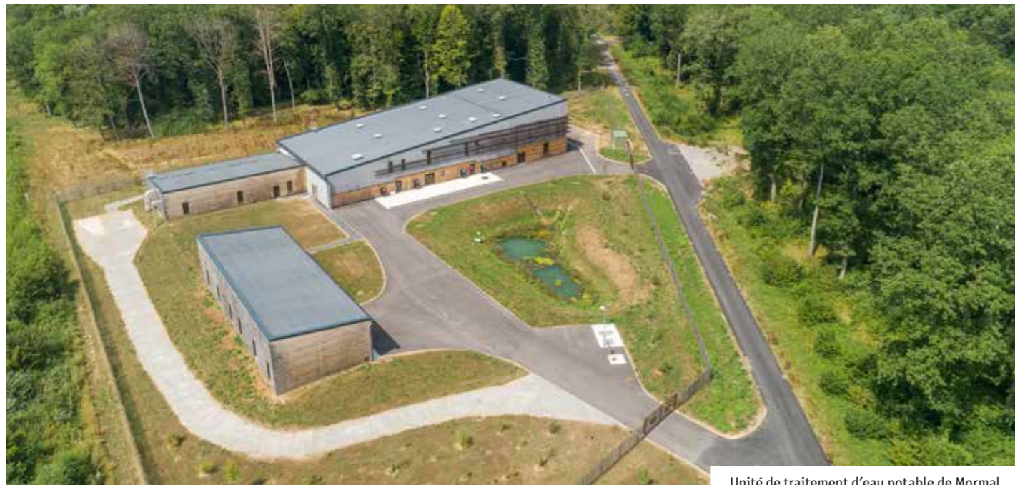
Unité de traitement d'eau potable de Mormal
