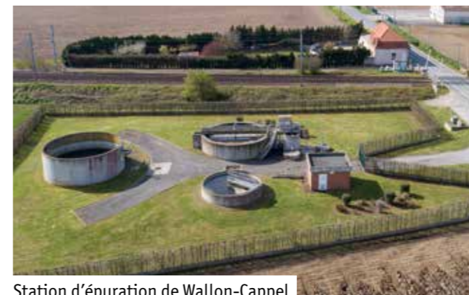
Station d'épuration de Wallon-Cappel
