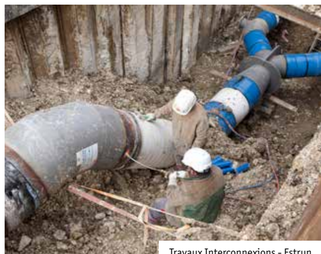
Travaux Interconnexions - Estrun
