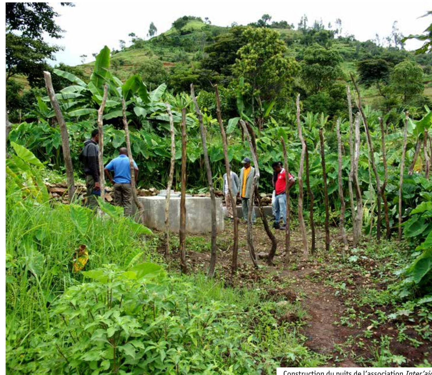
Construction du puits de l'association Inter'aide
