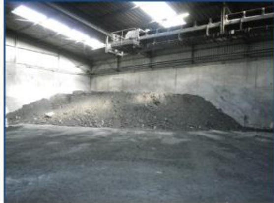
Photo n°2 : Hangar Stockage mâchefers
