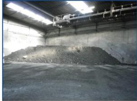
Photo n°2 : Hangar Stockage mâchefers
