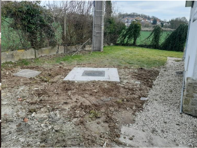
Photos après l'intervention
