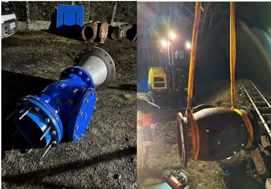
Photos pendant les travaux
