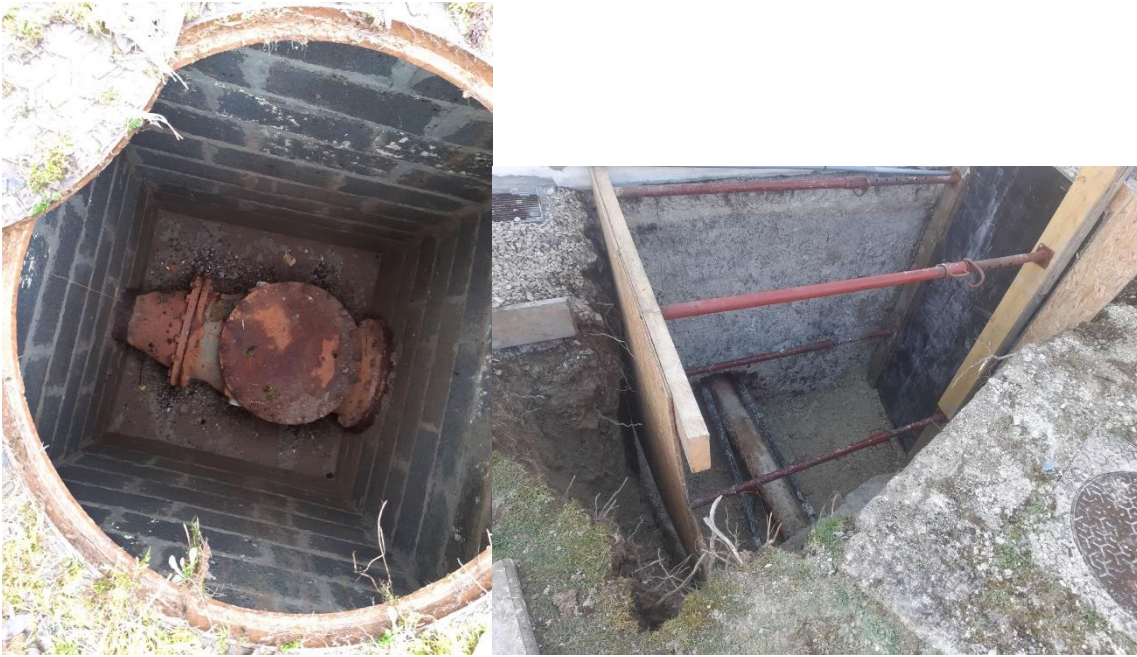
Photos réalisées lors des travaux préparatoires
