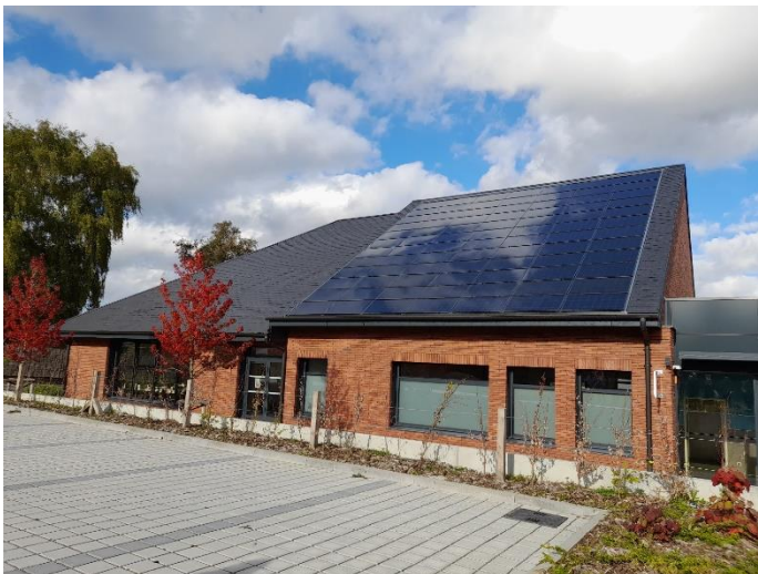
Figure 20 : Panneaux photovoltaïques à Burbure
